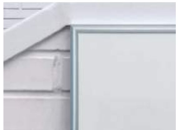
Detalle del perfil de aluminio anodizado plata mate
